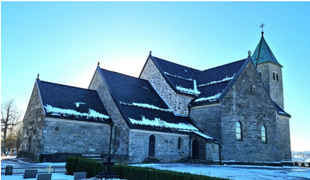
Gjerpen kirke klimaskallsikring
